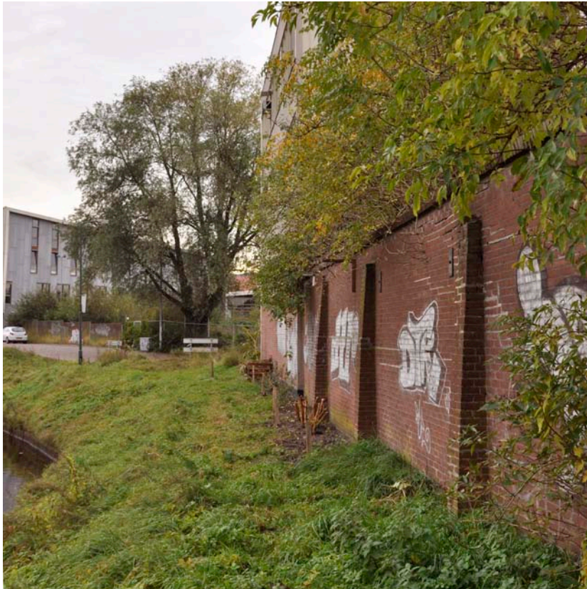
Afb.15: Bakstenen muur met steunberen.
