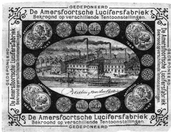
Afb.2: Paketiket uit omstreeks 1885, waarbij het bouwvolume en de bouwhoogte van het complex sterk is overdreven. Ook het aantal schoorstenen is opmerkelijk.
