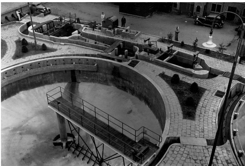
Afb.6. Regenwaterbassin, met erachter de zandvanger en olieafscheider, ca.1938
