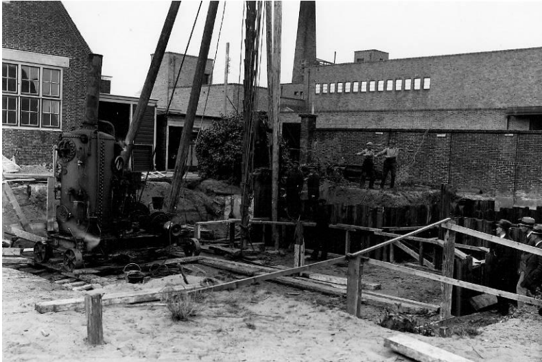
Afb.4. Bouw van het pompgebouw, met op de achtergrond het ontsmettingsgebouw, de ommuring en het abattoir, ca.1936
